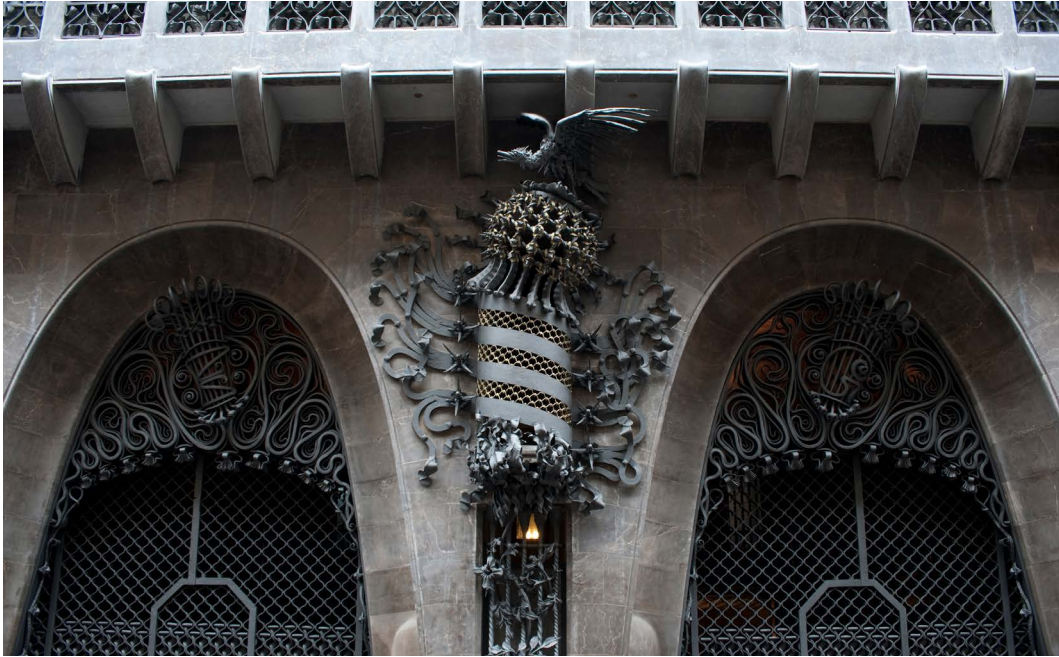
Els arcs de forma catenària característics del Palau Güell. Ramon Manent / Diputació de Barcelona.
