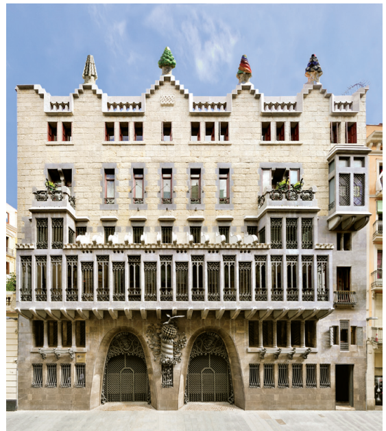
Imatge actual de la façana del Palau Güell. Fotografia: Montserrat Baldomà.
